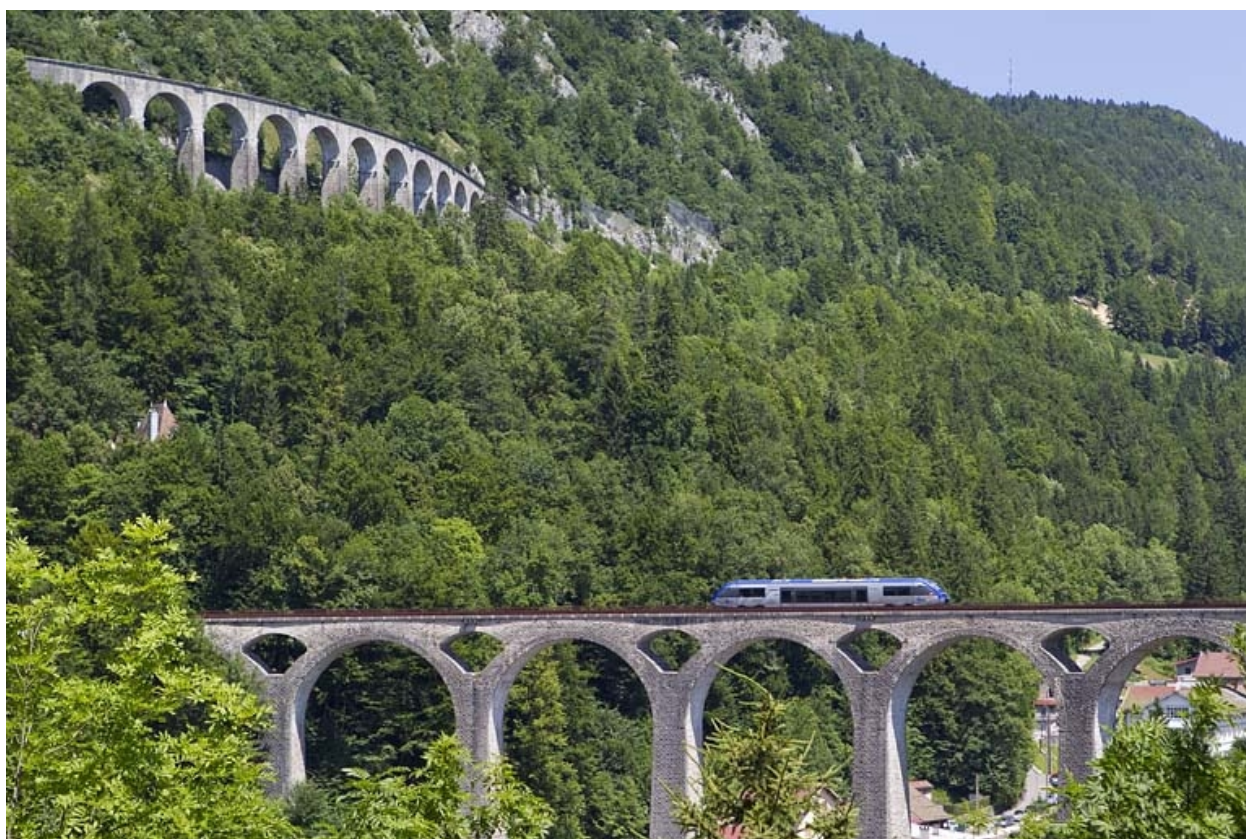
Le grand viaduc, avec celui des Crottes en arrière-plan (vue rapprochée).
