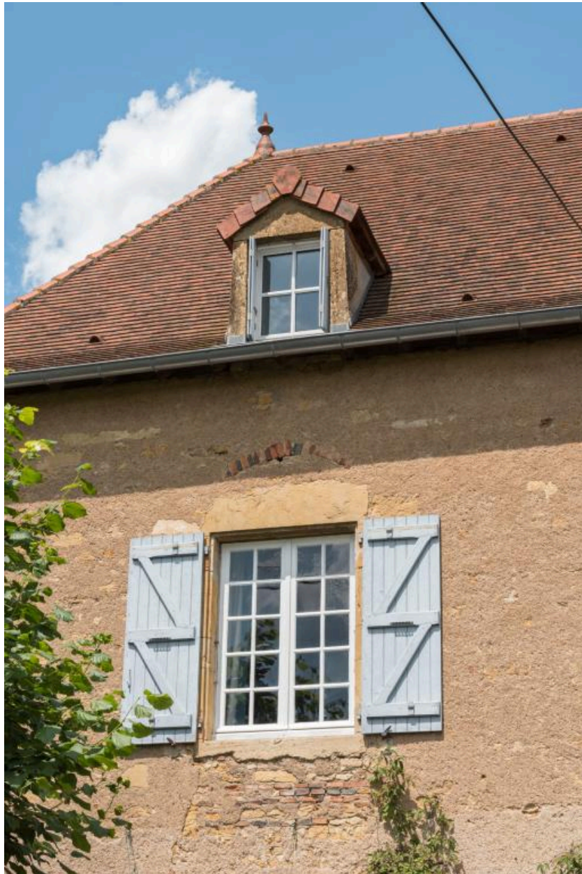
Détail de la façade antérieure de la maison (lucarne et baie de l'étage)
