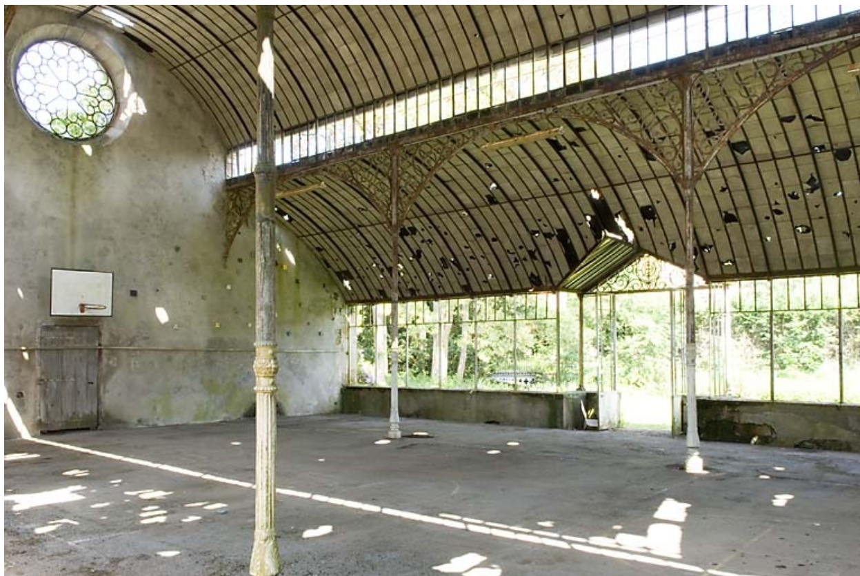
Intérieur de la serre. Vue de côté.
