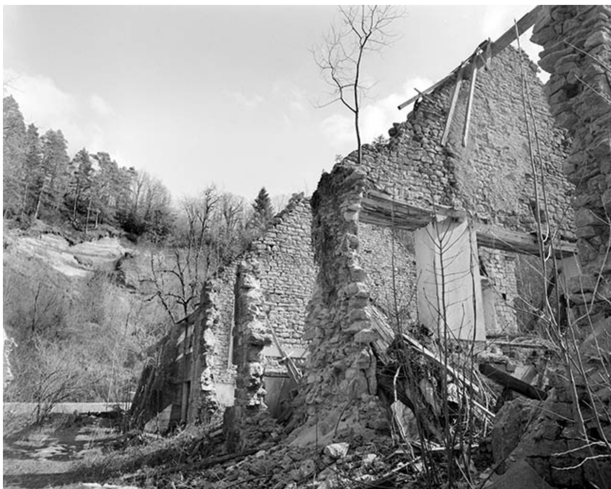
Murs de refend du logement patronal.
