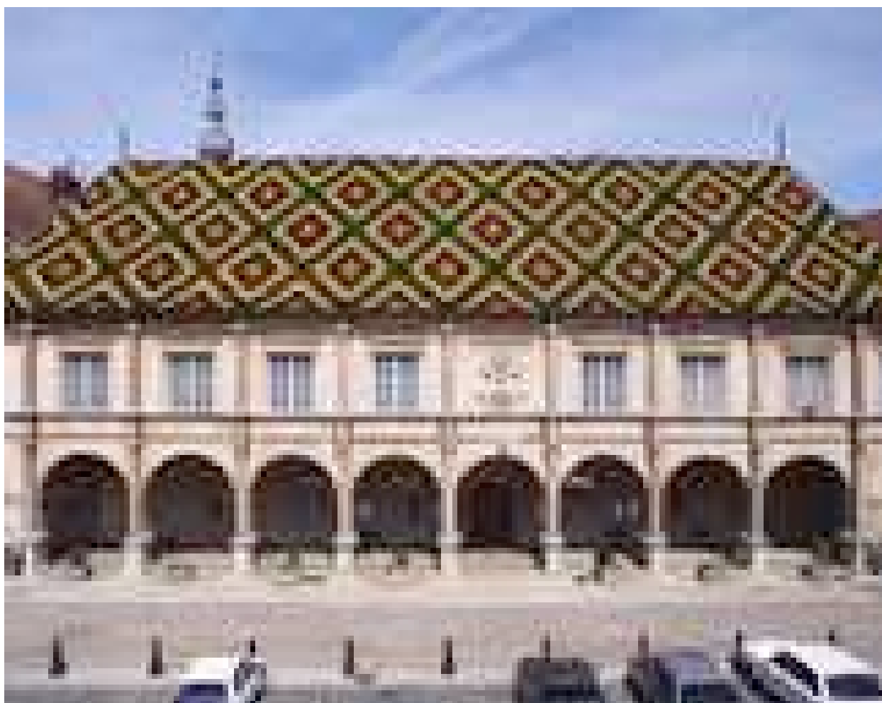
Détail de la façade de hôtel de ville : partie centrale.
