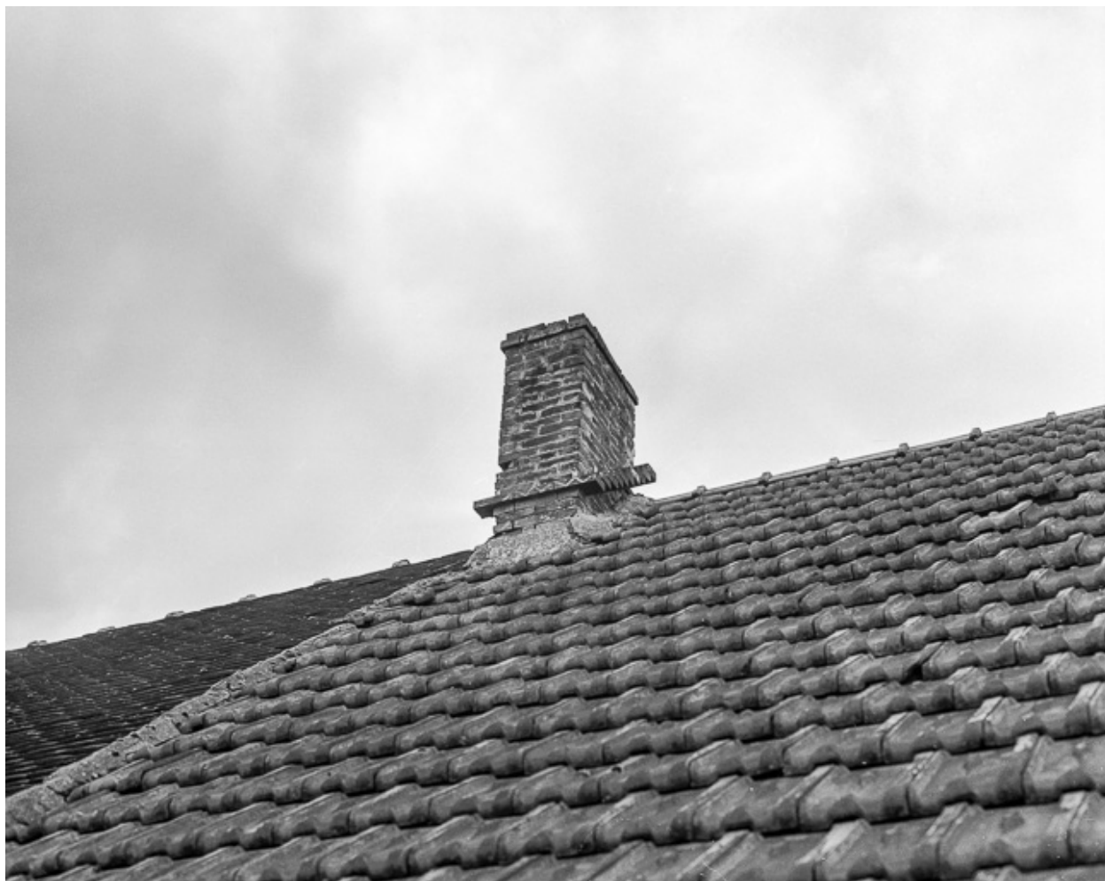
Vue du toit et de la cheminée.
