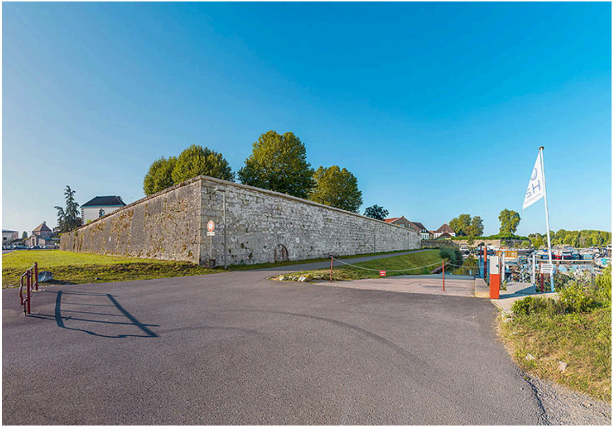
Vue générale du bastion et de son angle flanqué.
