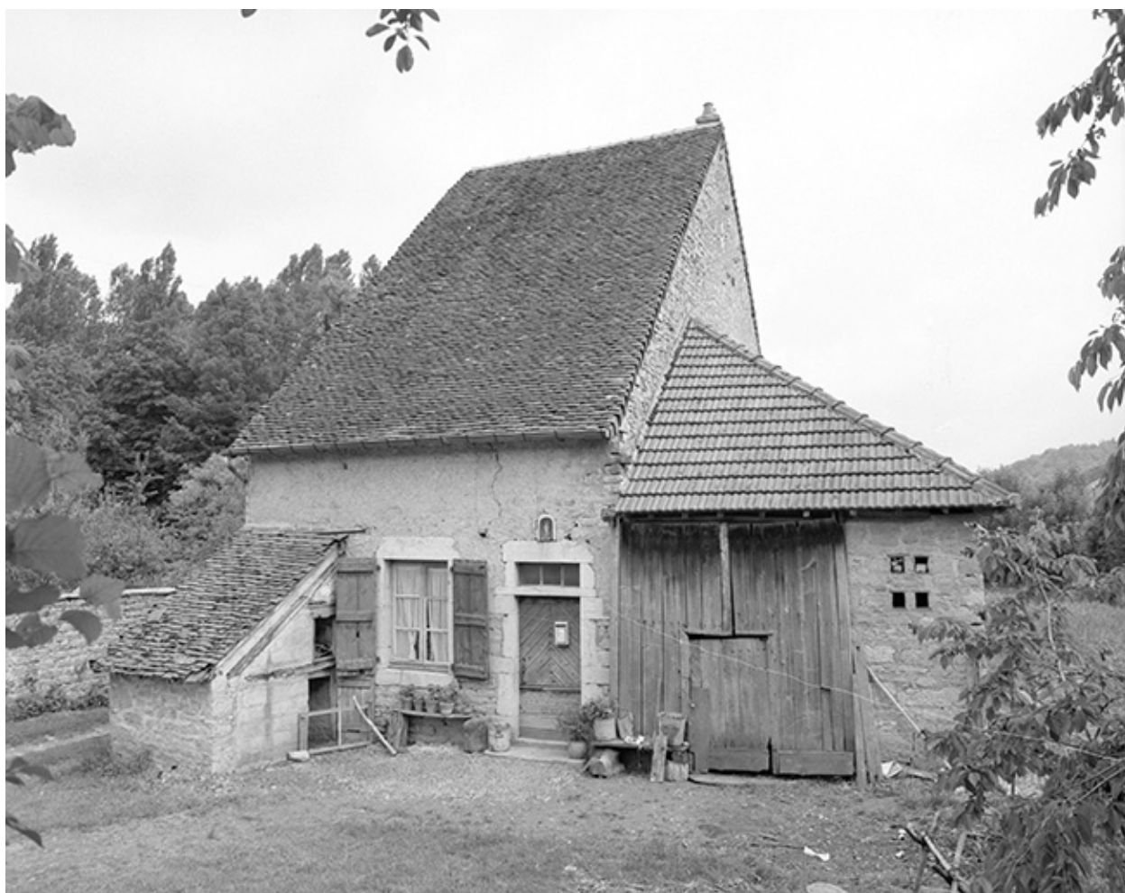
Maison : façade antérieure.
