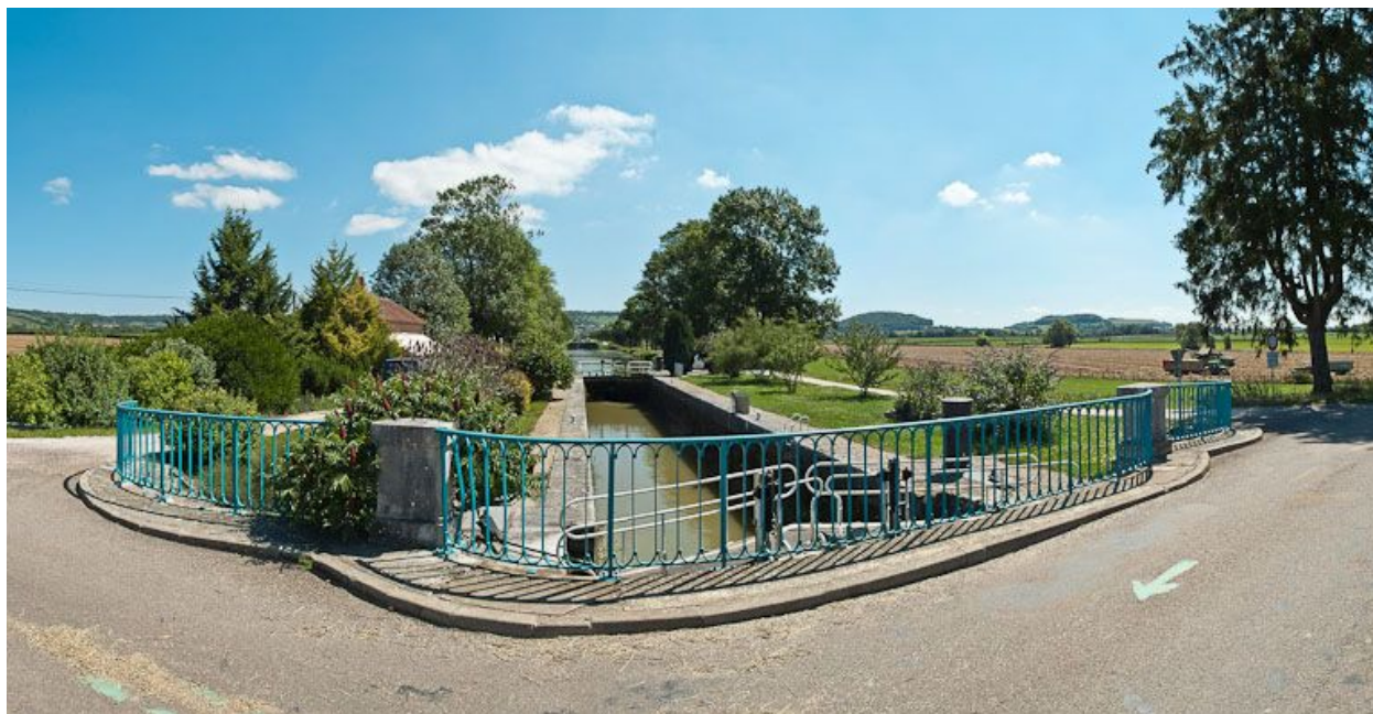
Vue du sas d'écluse depuis le pont.
