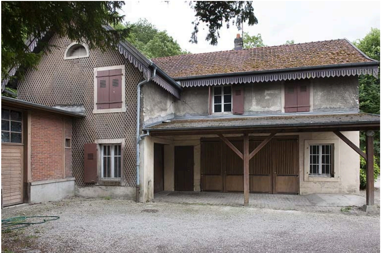
Façade nord des communs.
