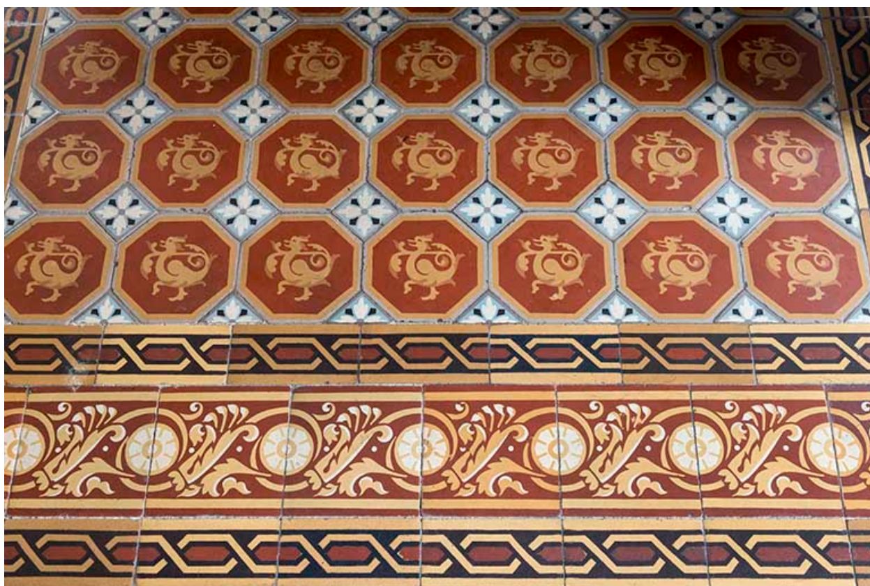
Le carrelage du foyer de la cheminée.
