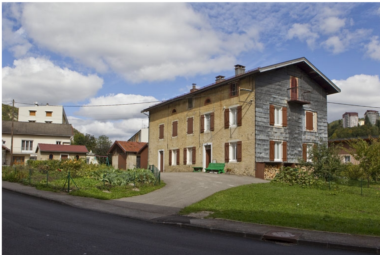
Ferme 42-44 rue Pasteur
