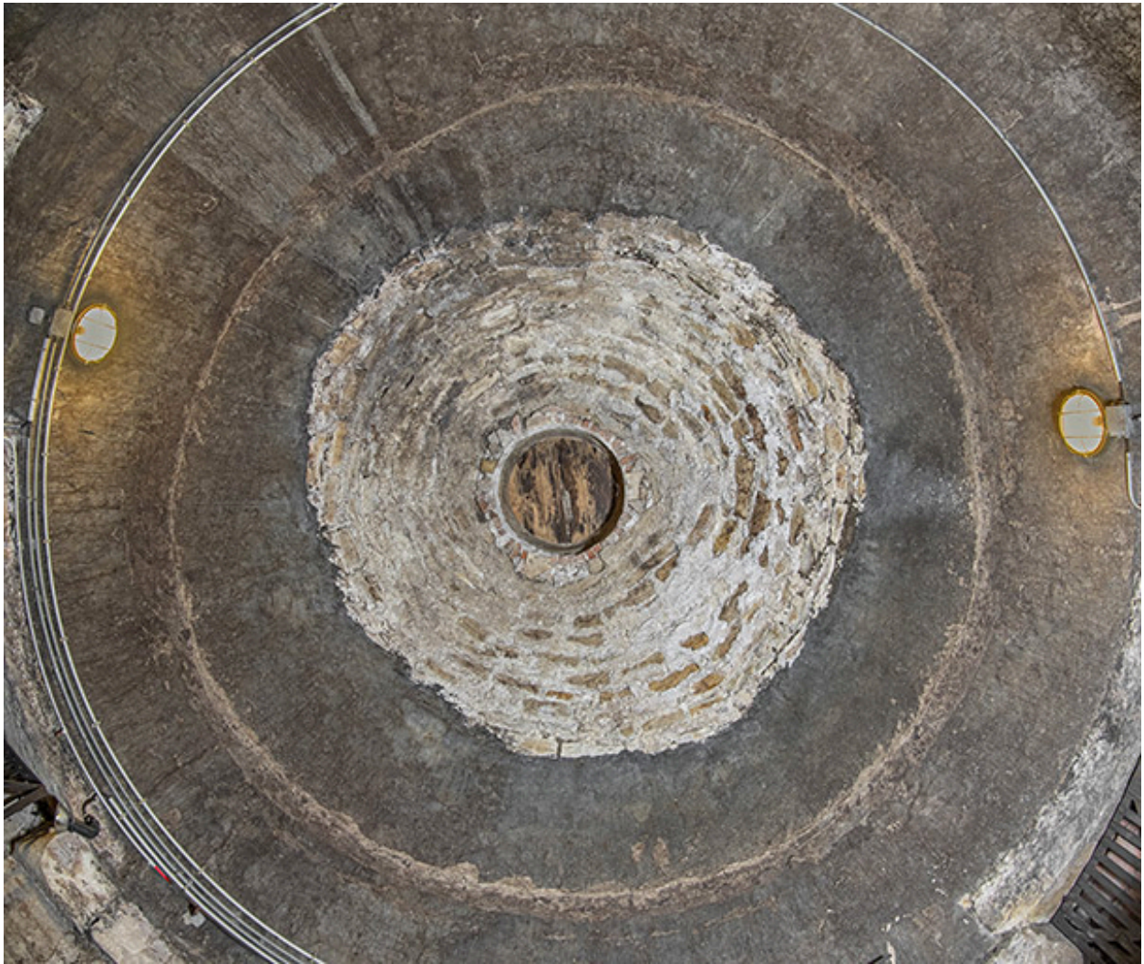
La tour des Cordeliers : plafond (ou couvrement) du niveau inférieur.
