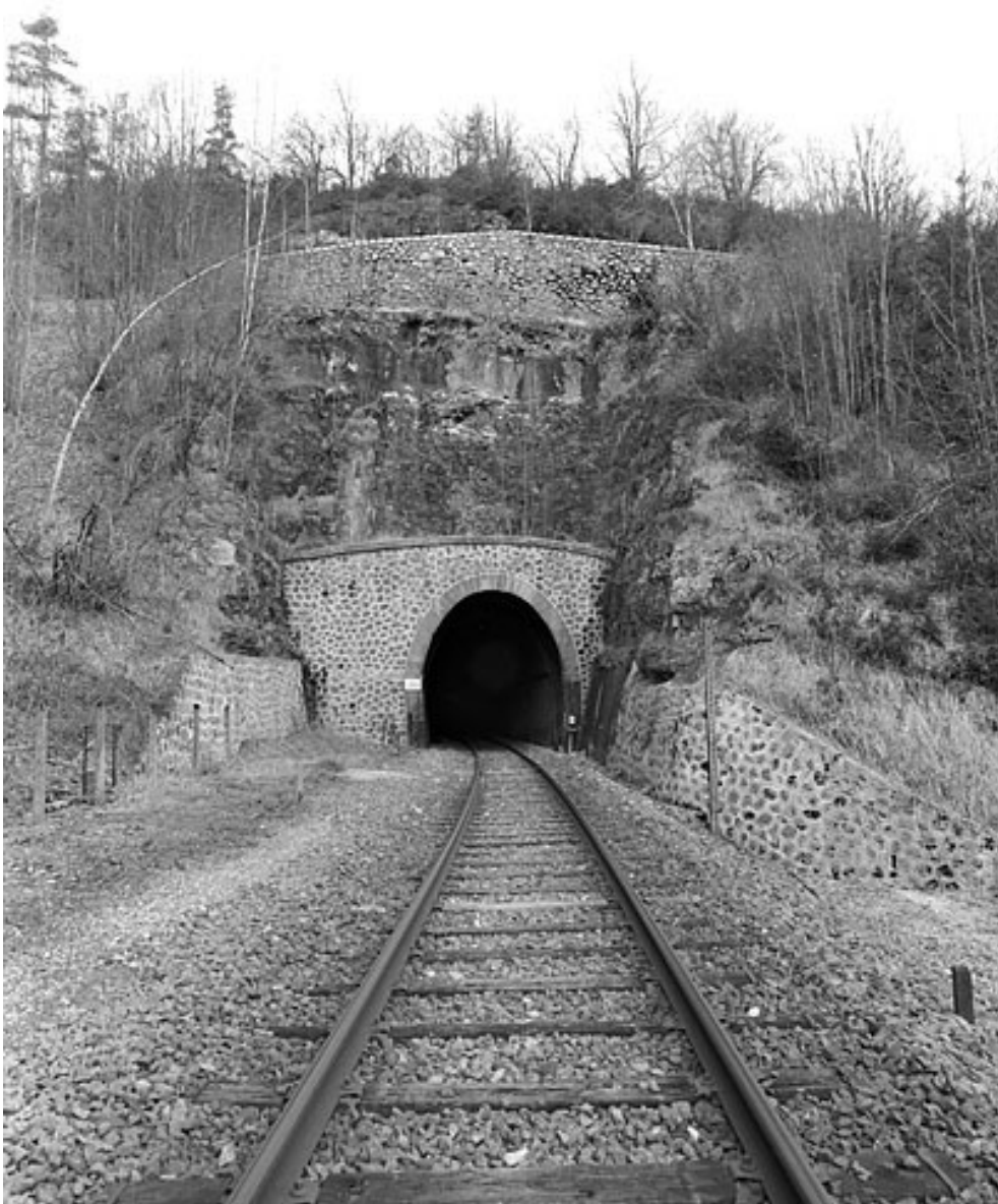
Tunnel : tête côté La Cluse (sud).
