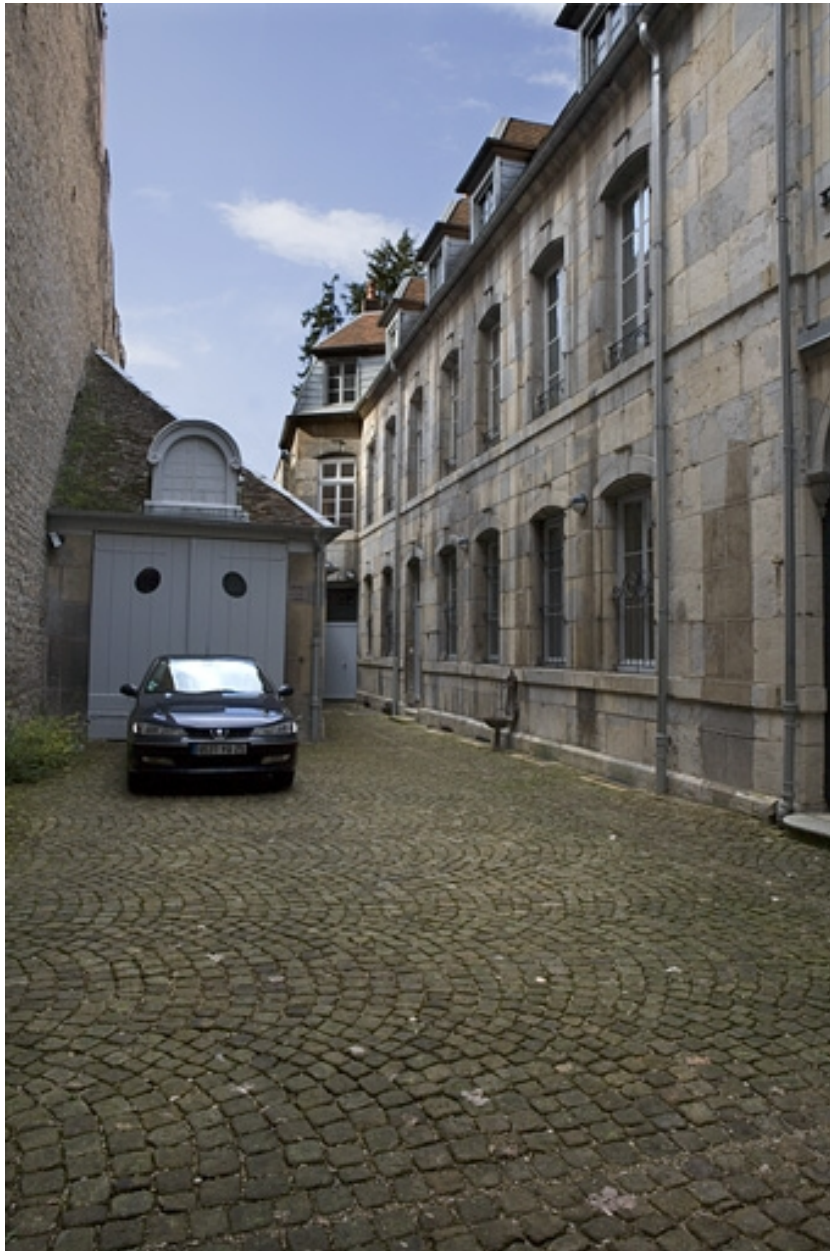
Vue d'ensemble de l' aile sur cour et du bâtiment des remise et écurie.
