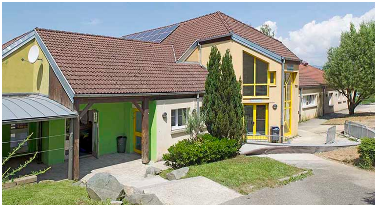
Angle sud-est de la restauration.
