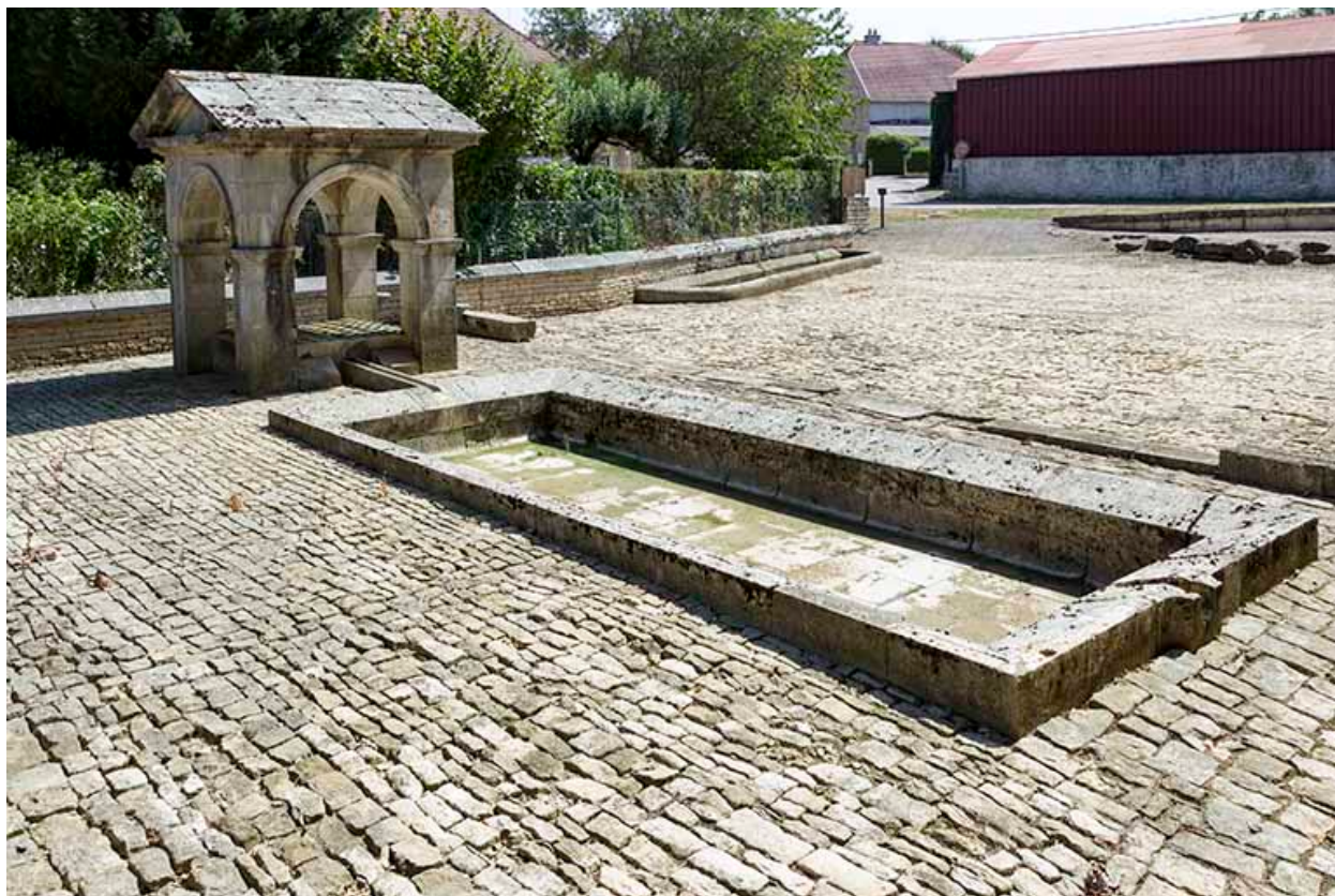
Lavoir et puits.
