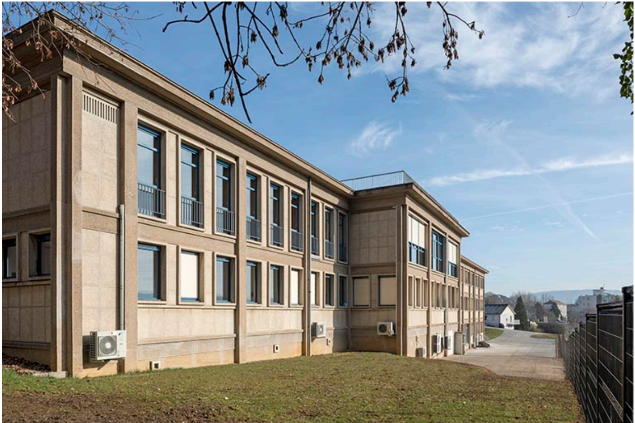
Façade postérieure : corps occidental, de trois quarts gauche.
