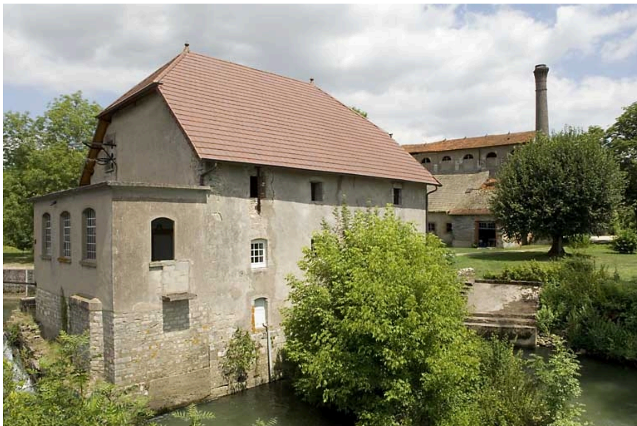
Moulin et haut fourneau depuis le sud-ouest.
