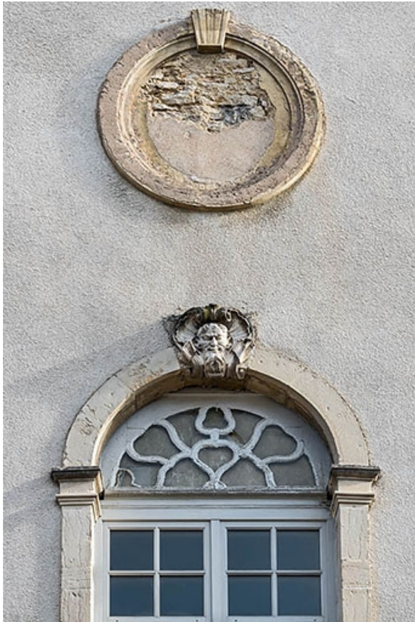
Façade antérieure, travée centrale : baies supérieures.
