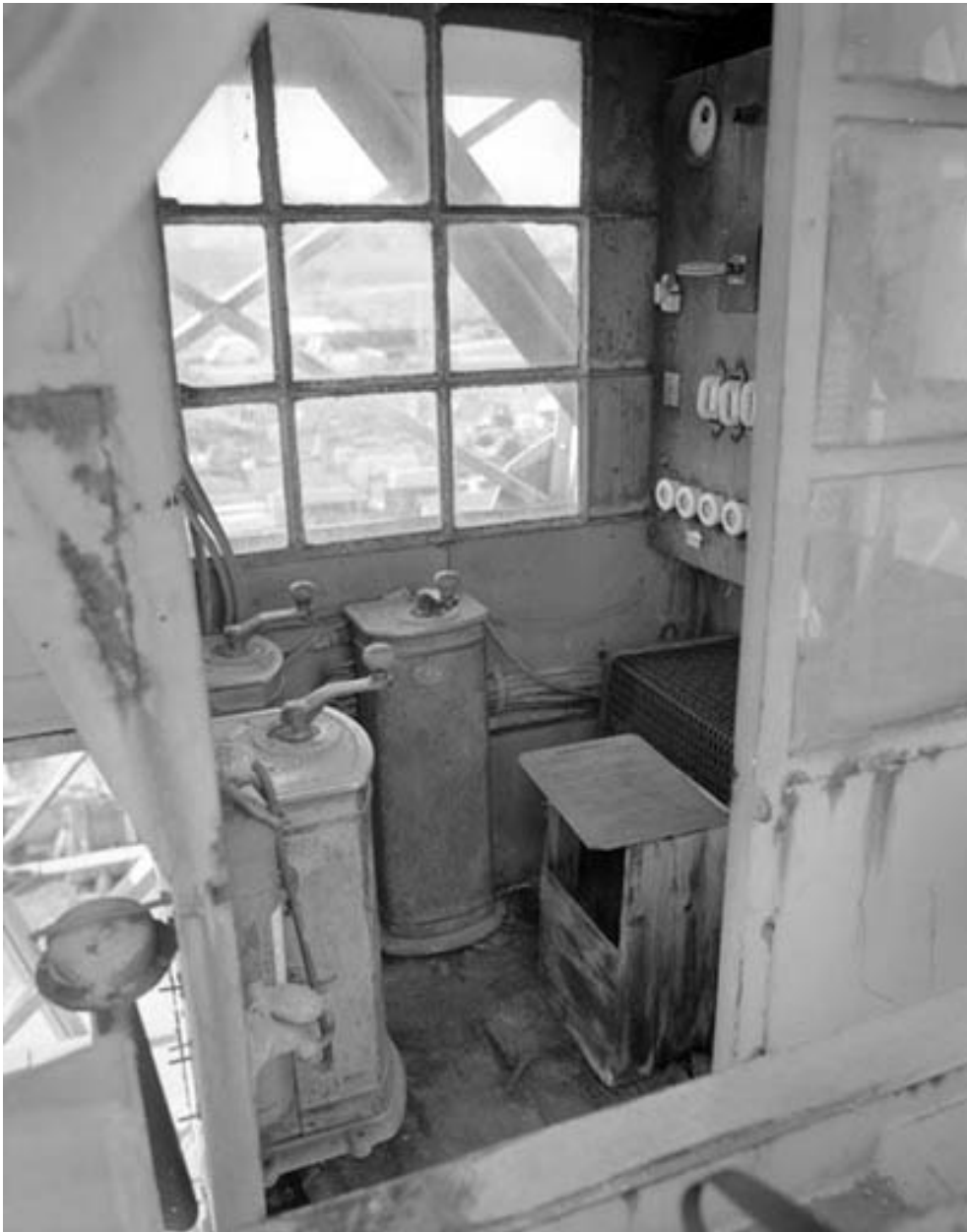
Intérieur de la cabine.
