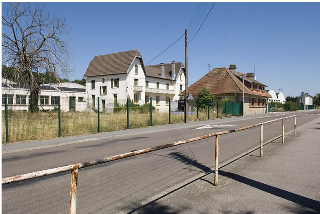
Logements, bureaux et conciergerie depuis l'ouest.
