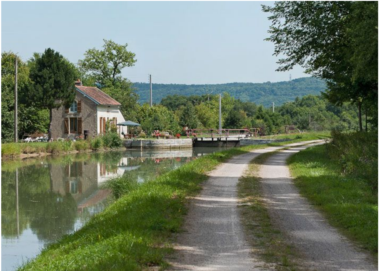
Vue du site d'écluse depuis l'amont.
