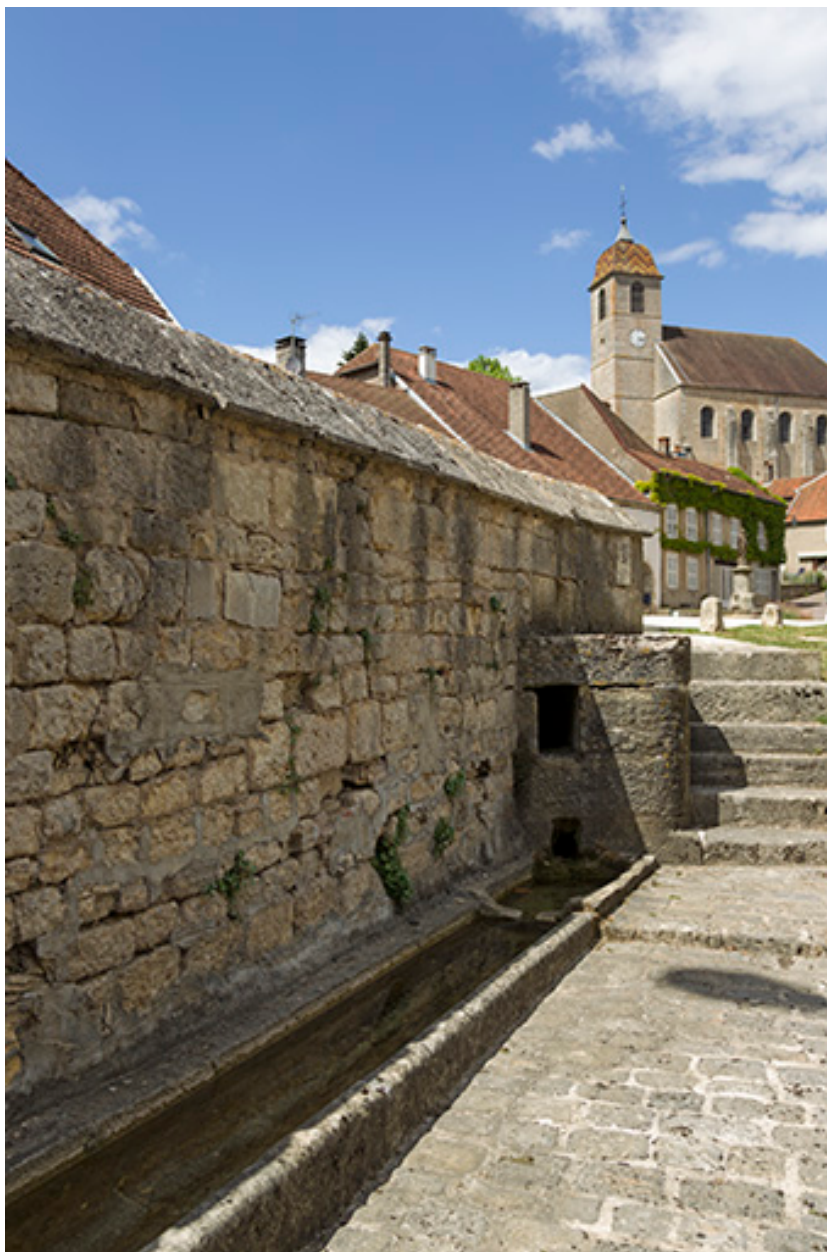
Fontaine-lavoir, 1 rue du Pâquis : l'arrivée d'eau.
