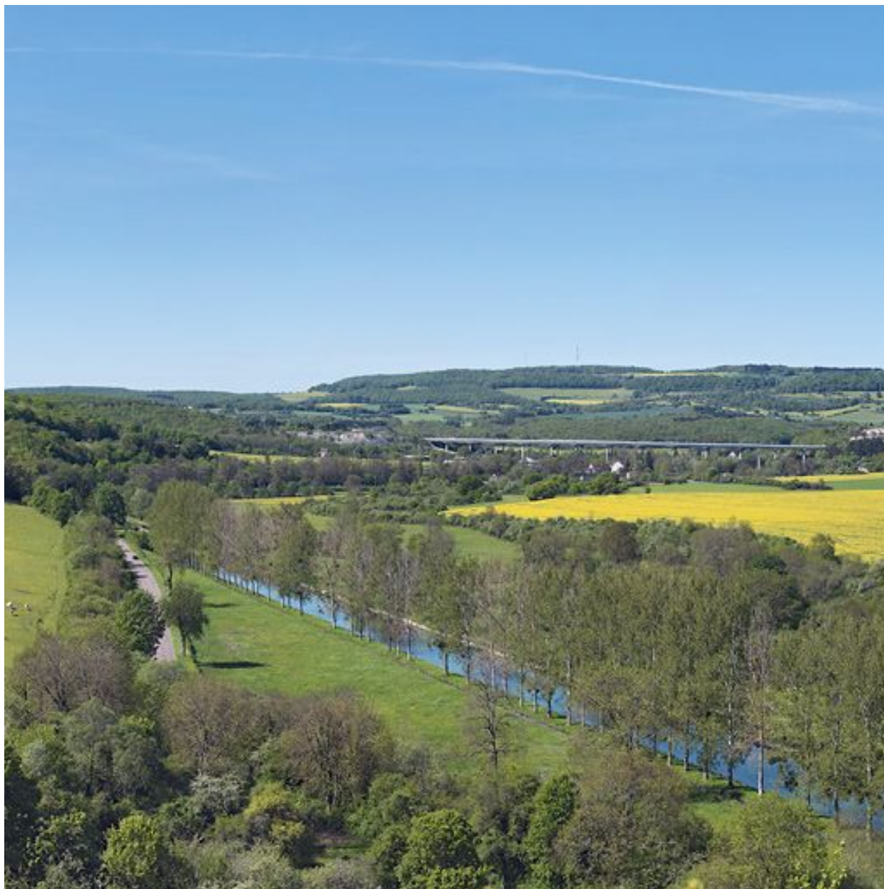
Le viaduc dans son environnement.
