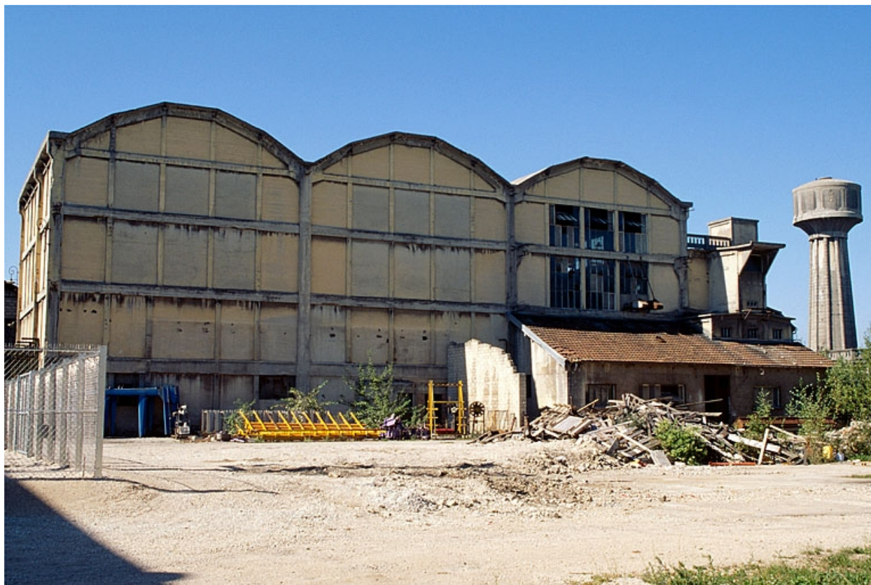
La centrale thermique depuis l'est.
