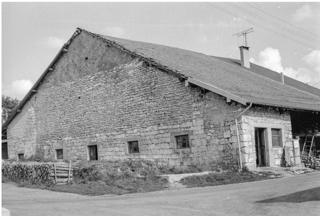
Ferme cadastrée 1945 D 120 : vue d'ensemble.
