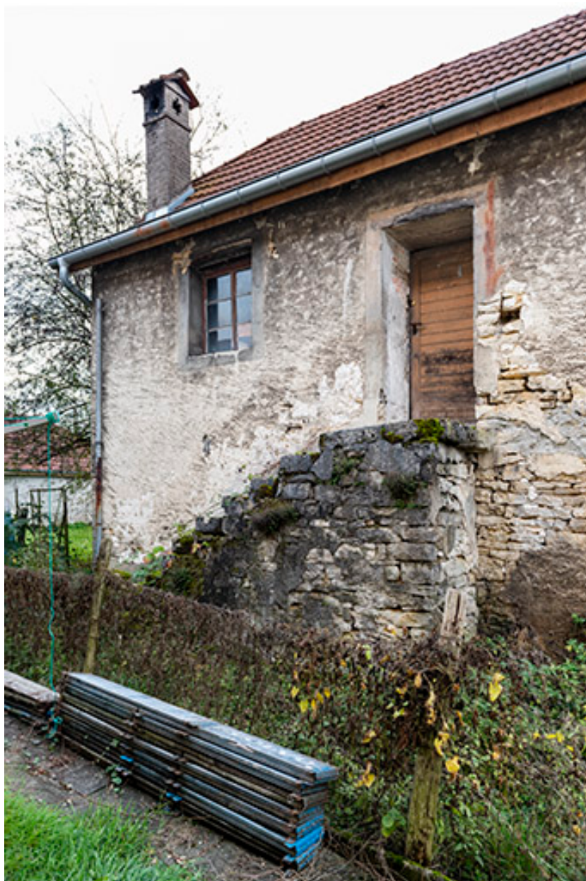
Forge : façade latérale gauche.
