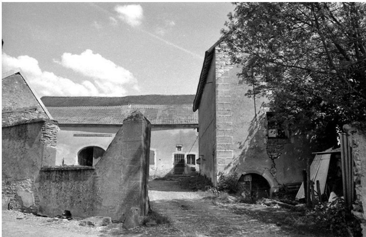
Vue d'ensemble depuis l'entrée de la cour.
