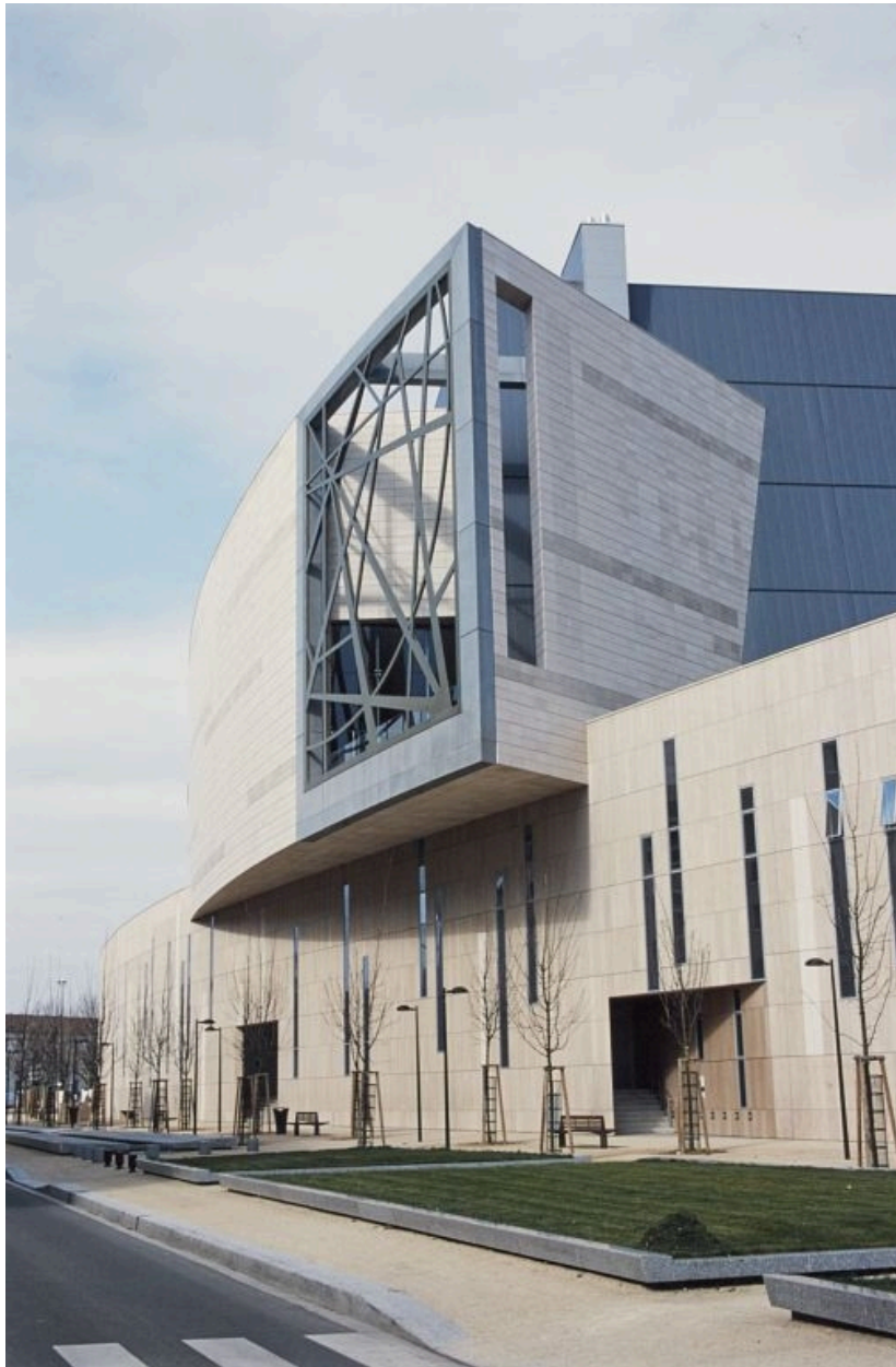
Elévation latérale, boulevard de Verdun, en 2000.
