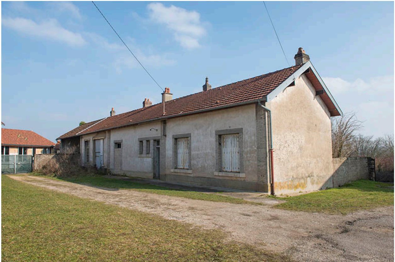
"Au bas de la caserne" : vue de trois quart des logements, angle nord-ouest.
