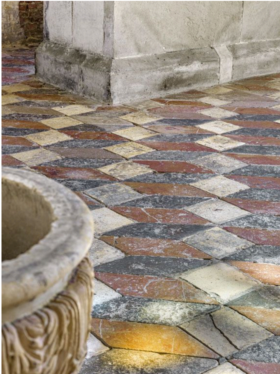
Intérieur de la chapelle : dallage du chœur.
