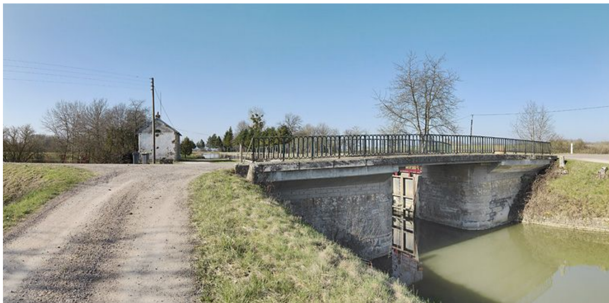
Le pont vu d'aval.
