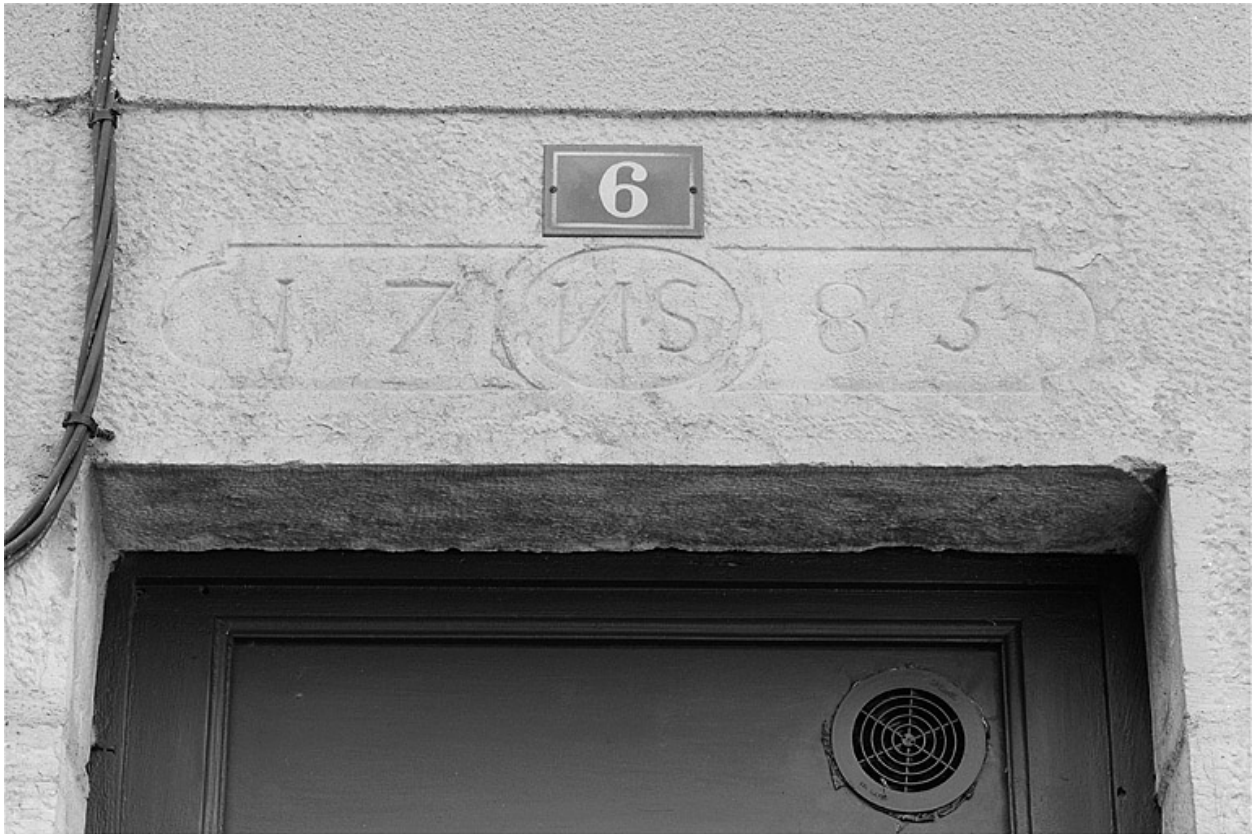
Façade ouest. Détail d'un linteau de porte.
