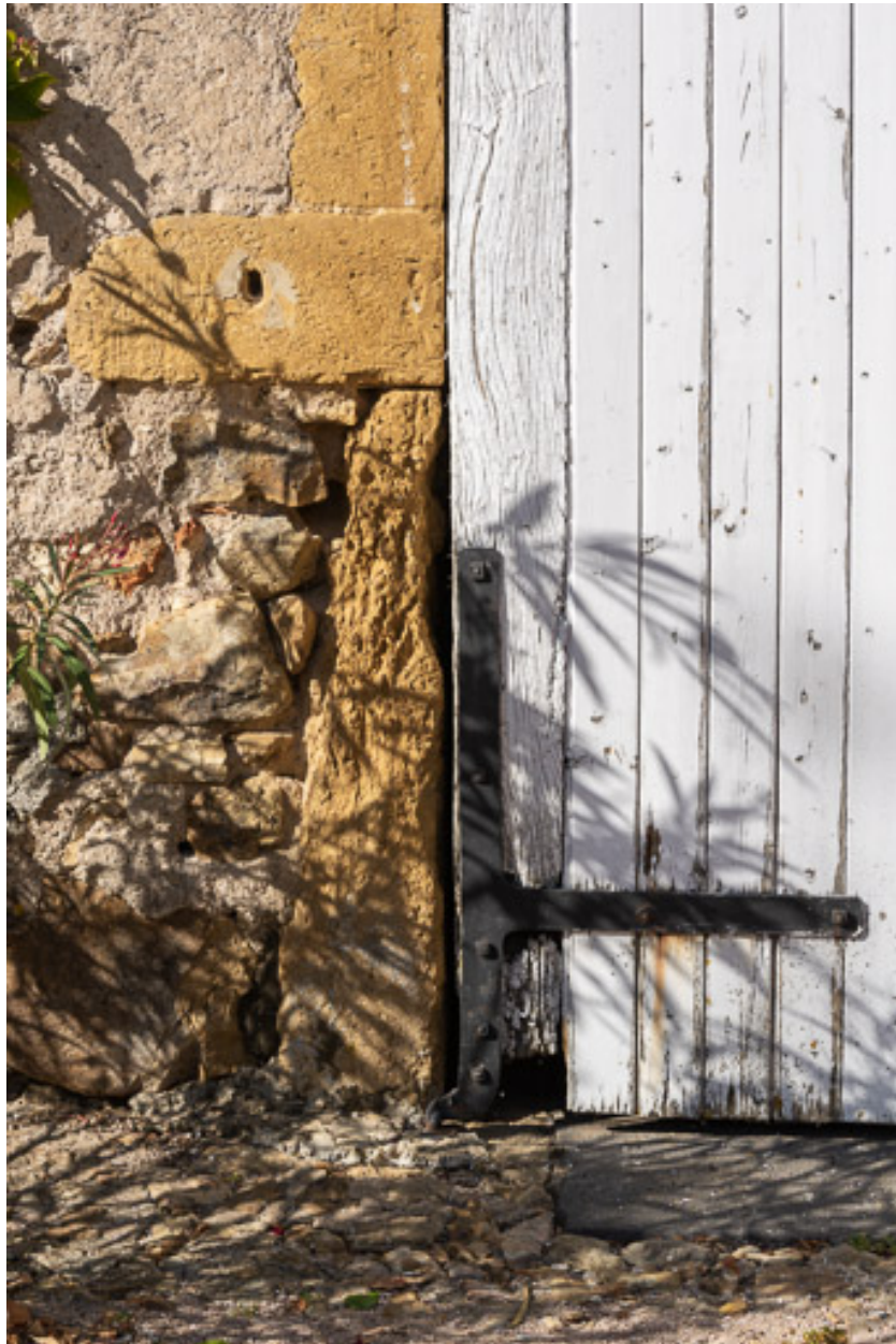
Détail de l'encadrement de la porte de la remise
