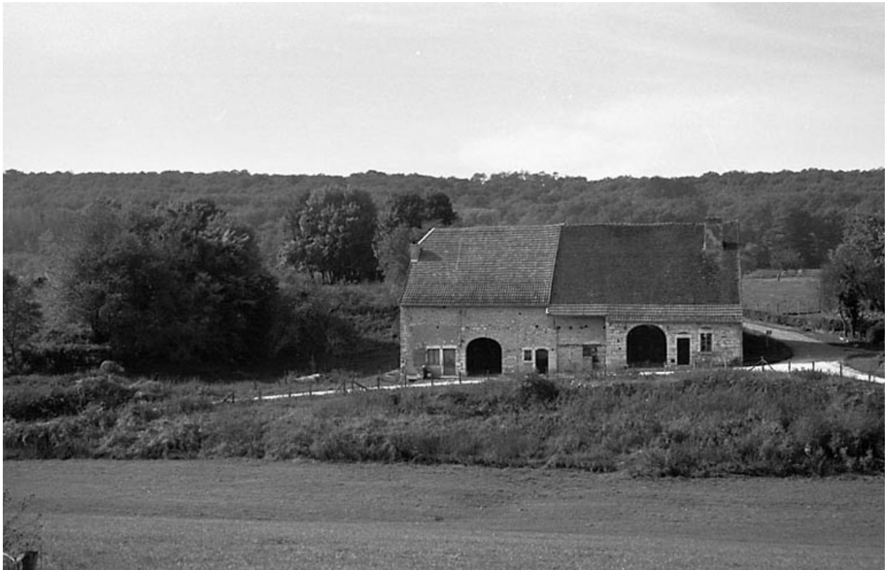
Ferme située au lieudit Les Brosses.
