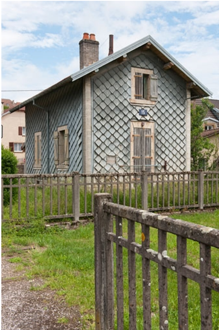
Maison de garde-barrière, rue du Pont : vue rapprochée.
