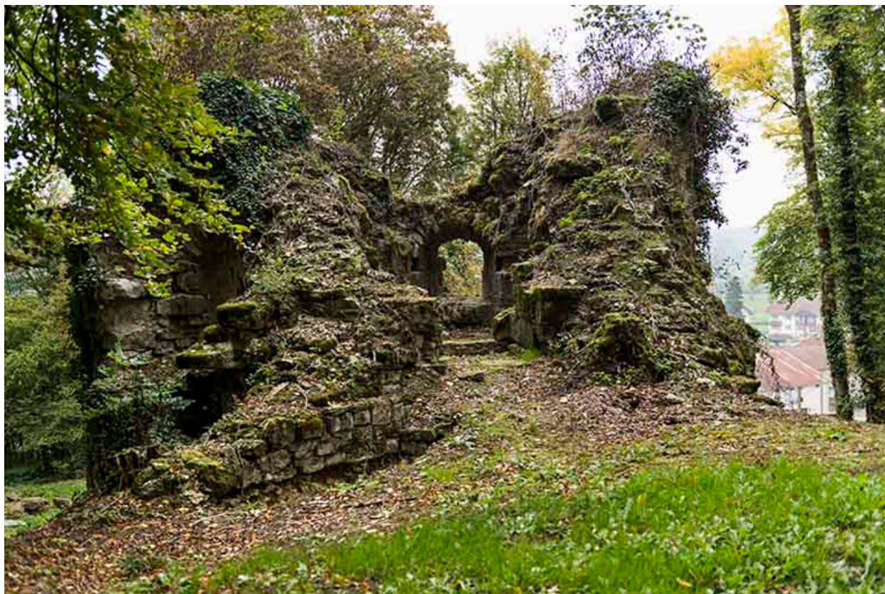
Vue sur la tour est.
