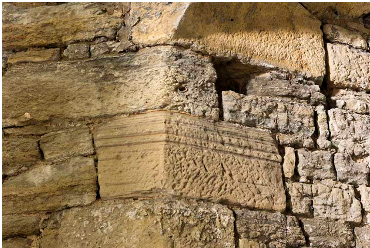
Détail de maçonnerie.
