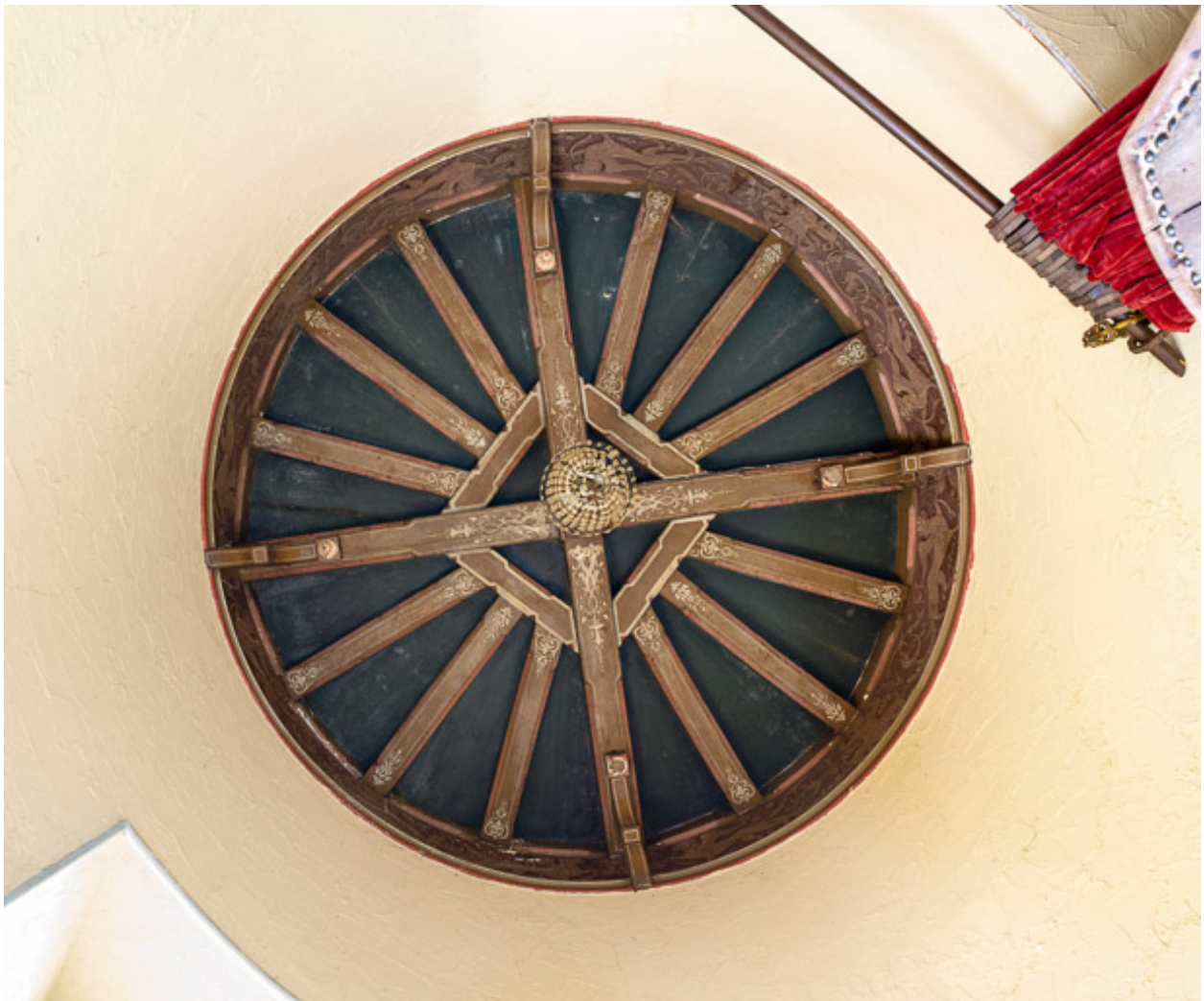
Plafond de la tourelle de l'escalier en vis.
