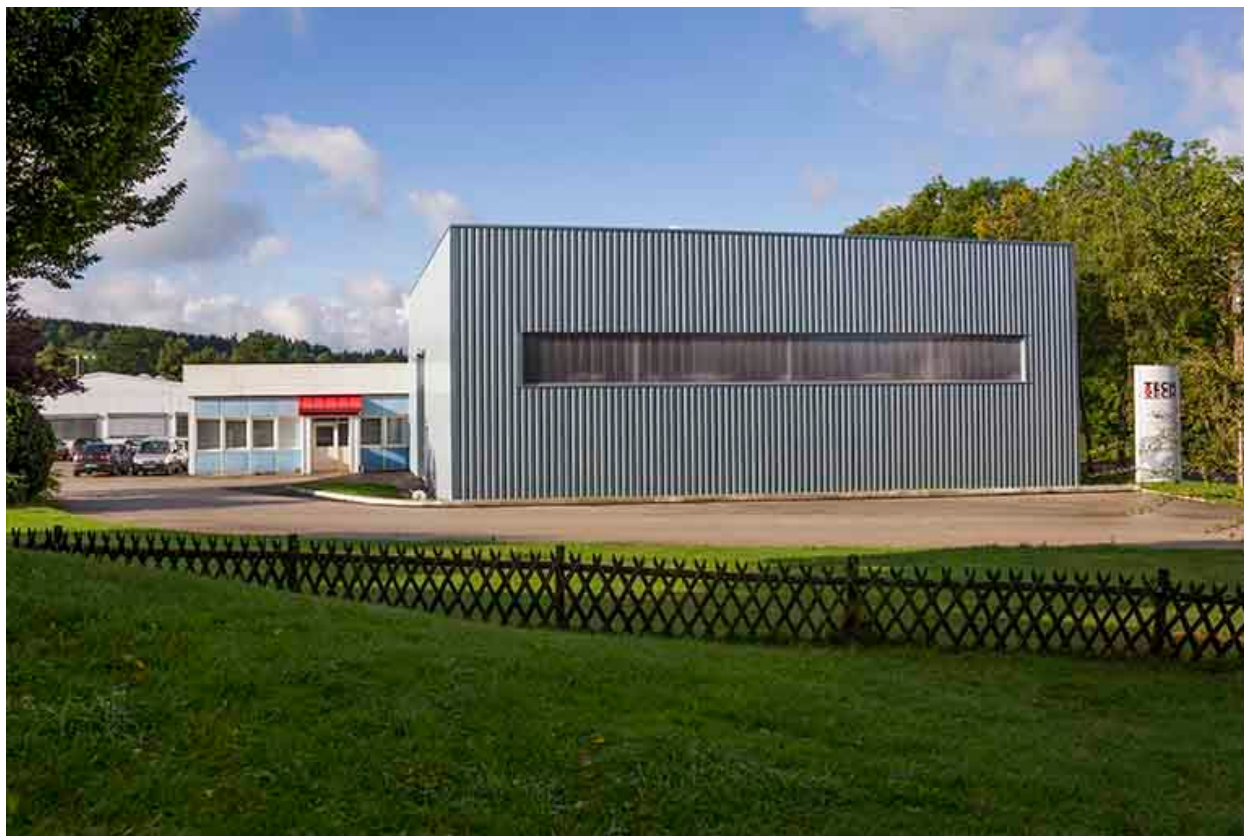
Façade antérieure (atelier de 2013 au premier plan).
