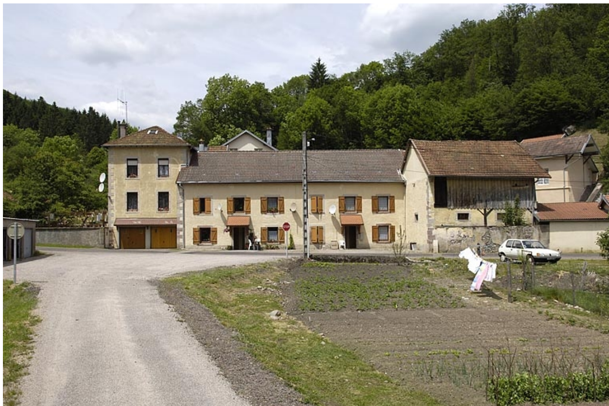
Logements vus depuis le sud.
