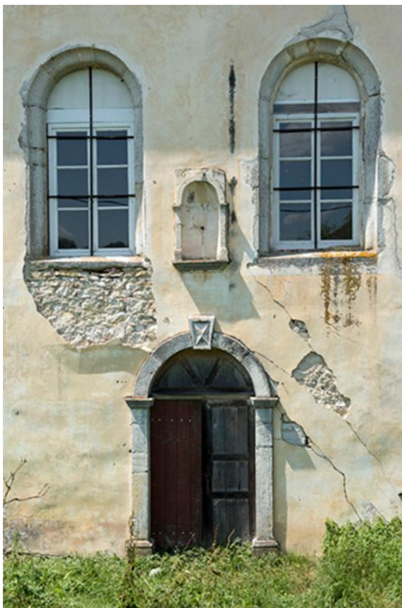
Façade principale de la chapelle
