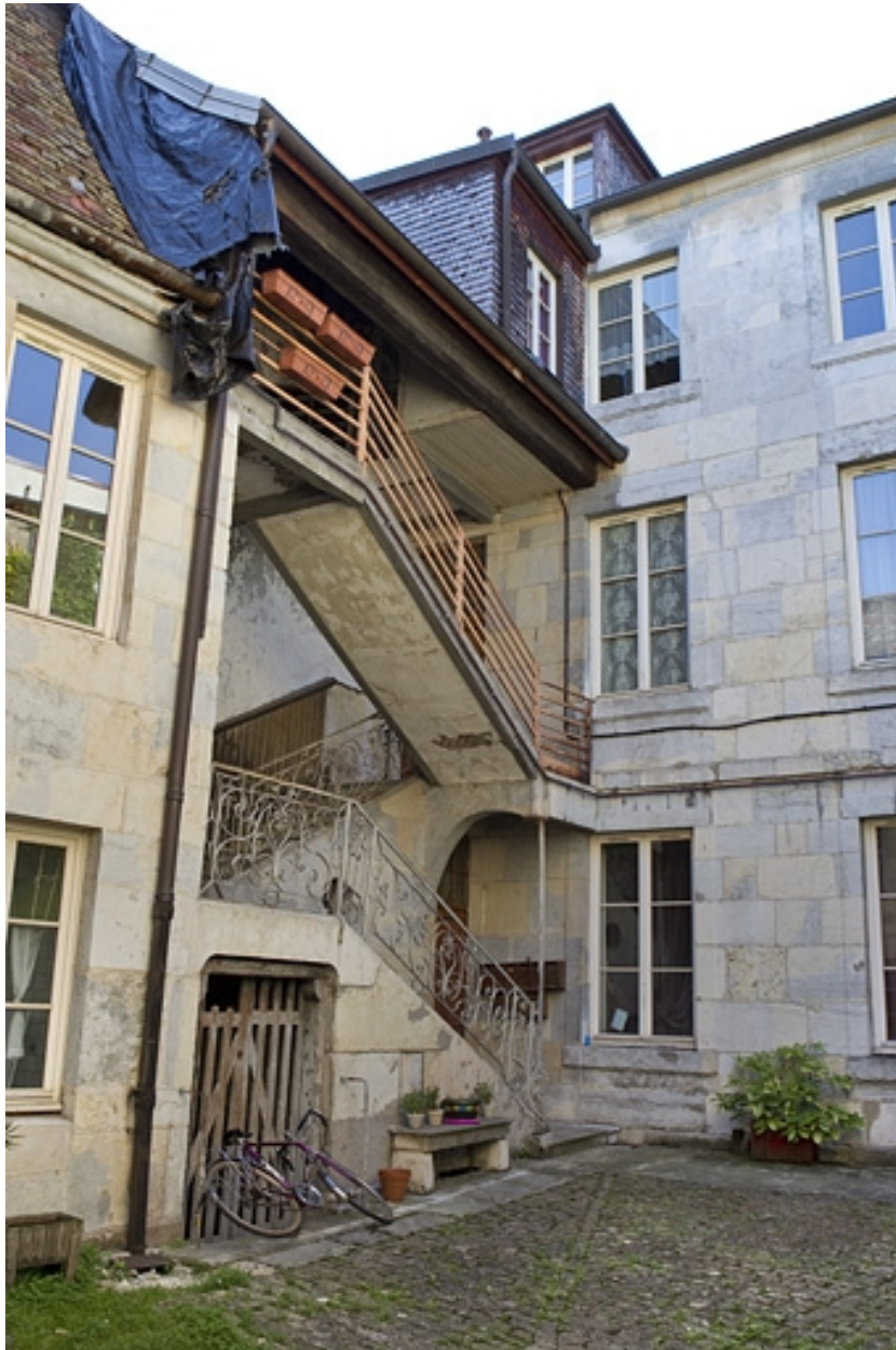
Vue d'ensemble de l'escalier à cage ouverte.
