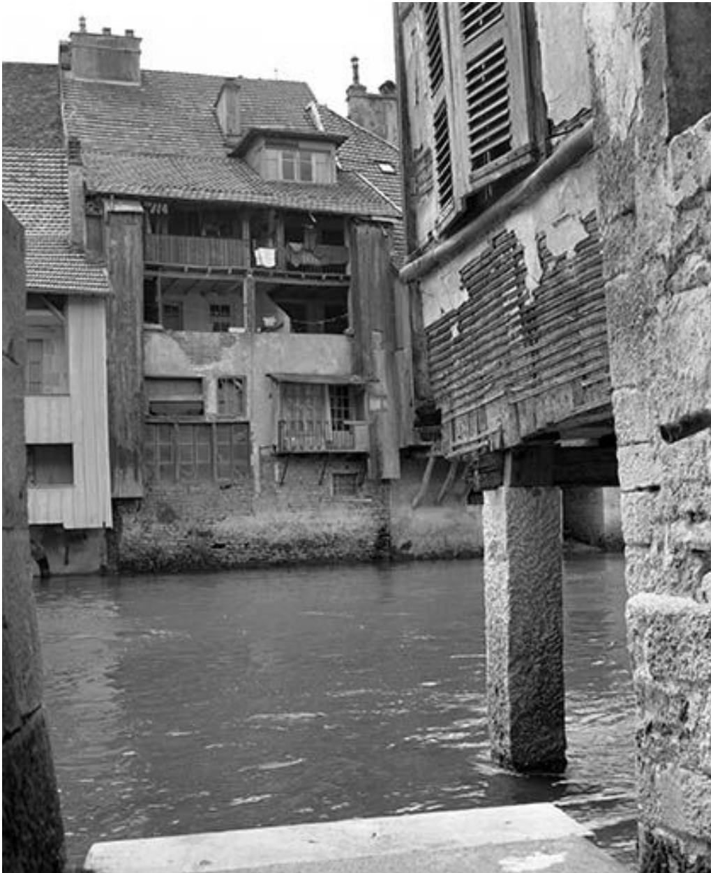
Maison rue Saint-Laurent depuis la rive droite de la Loue.
