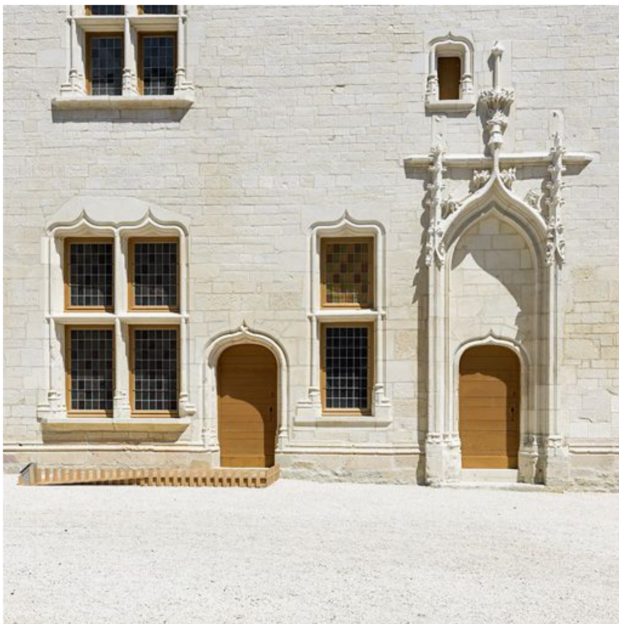
Logis des Hôtes : détail de la façade.
