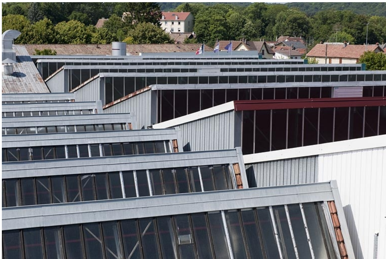
Toitures de l'atelier de fabrication ouest.
