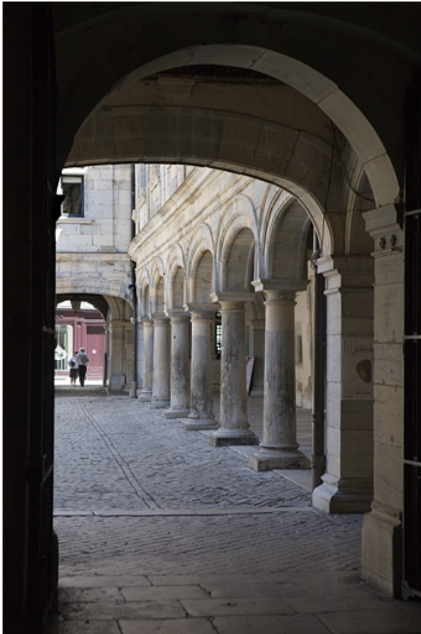
Vue du portail d'entrée sur rue depuis le portail donnant sur l'ancien jardin.
