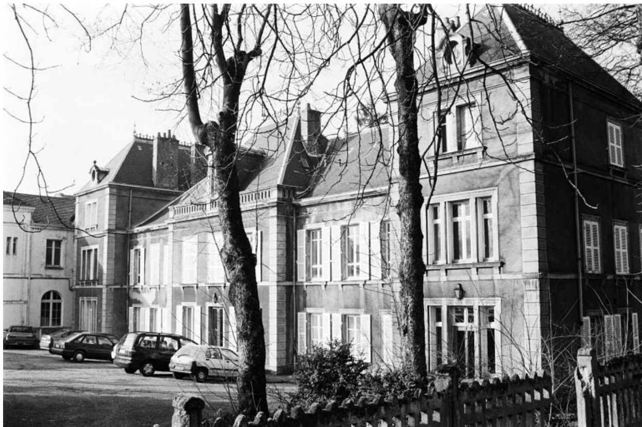
Façade antérieure de la " maison d'administration ".
