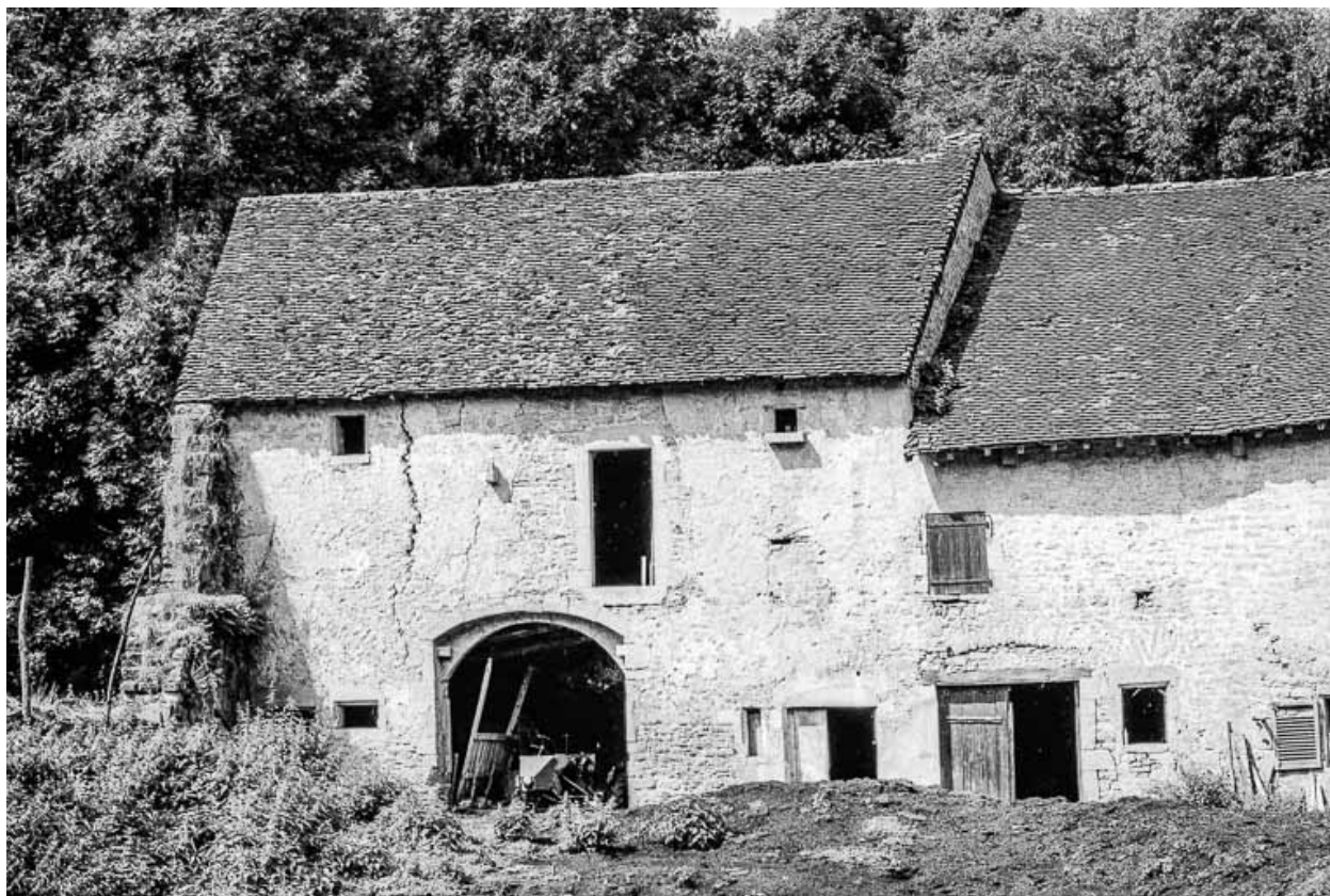
Partie agricole : façade sur cour.
